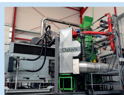
Q-PowerGen System der Firma Qalovis: Kombination aus Biomassevergassungssystem mit FlexGen Stirling Generatoreinheit zur parallelen Erzeugung von Wärme und Strom.
